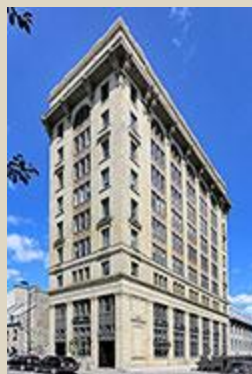
L'édifice de La Sauvegarde vu de la rue Notre-Dame Est. ©Denis Tremblay, 2014
