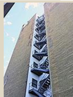
Détail de l'élévation latérale. ©Denis Tremblay, 2014
