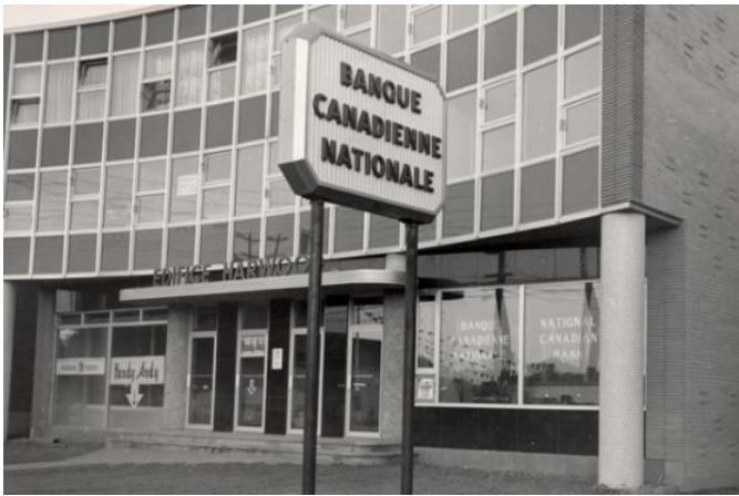
Ancienne succursale de la Banque Nationale du Canada à Dorion en 1959 (182, boulevard Harwood). © Collection patrimoniale Banque Nationale, BCN 431.
