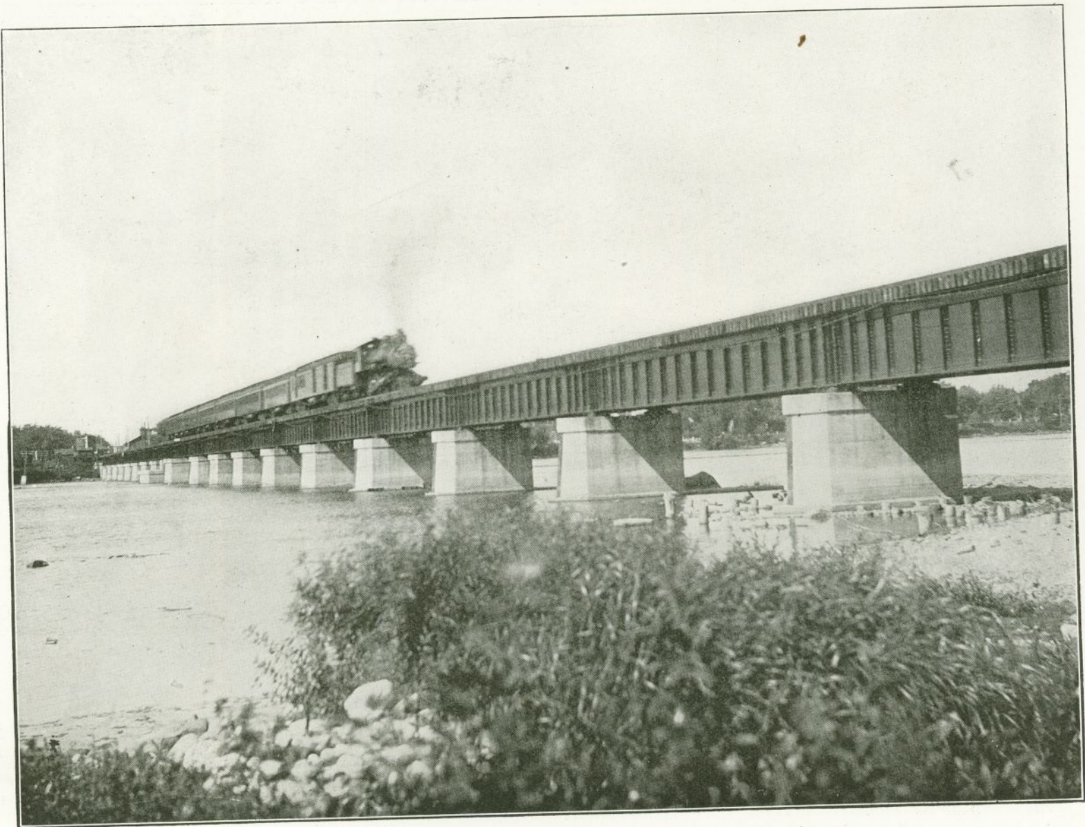
Canadian Pacific Railway Bridge, over Richelieu River, between St. Johns and Iberville. Pont du chemin de fer Canadien du Pacifique entre Saint-Jean et Iberville.
